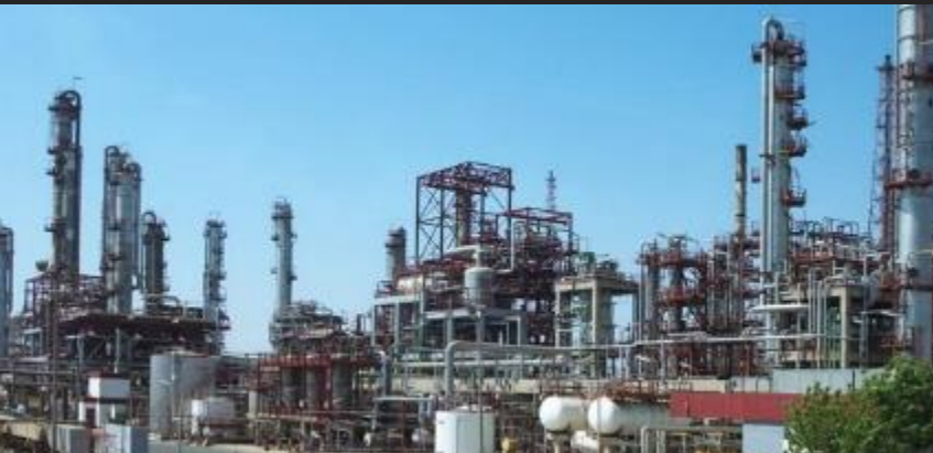
Refinería Huelva (España)
