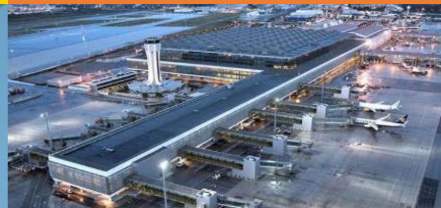
Centro Proceso de Datos Aeropuerto Málaga (España)
