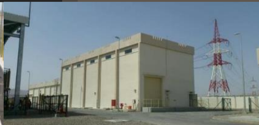
Subestación Al Dreez 132/33 kV (Omán)
