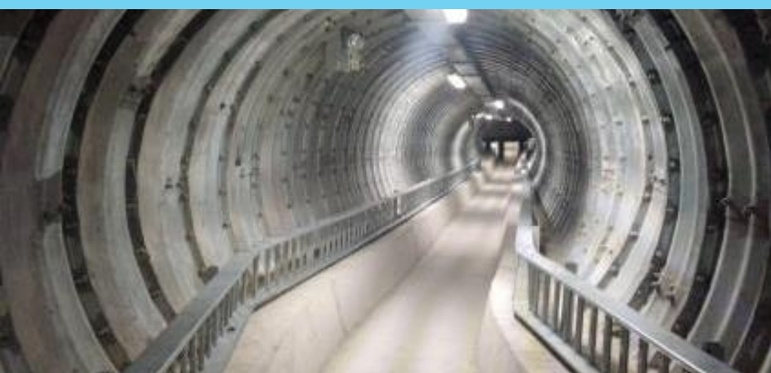
Electrificación Líneas 3 y 6 Metro de Santiago (Chile)
