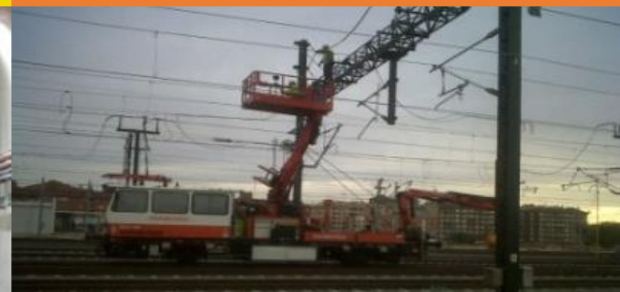
Mantenimiento LAV Madrid-Barcelona-Frontera Francesa (España)
